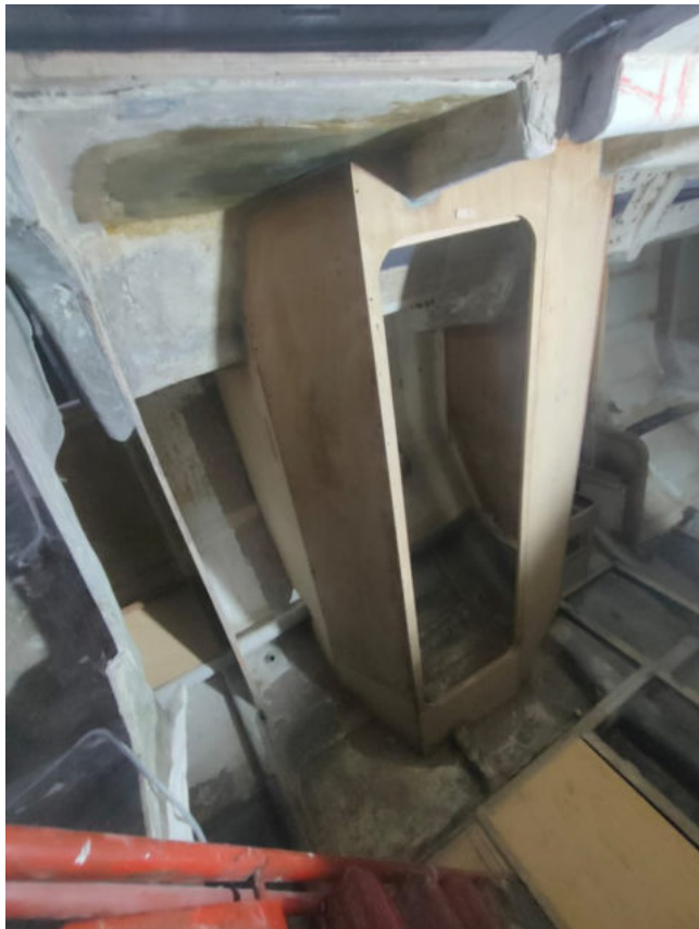
Realizzazione bagno piccolo
